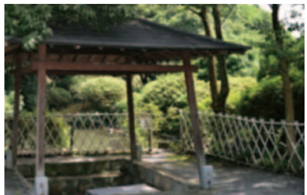
写真5. 保護柵の状況
